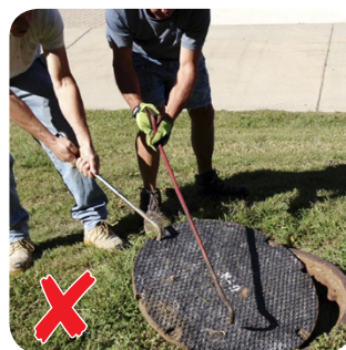
Pericolosa manovra di apertura
