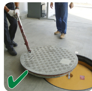
Tecnica di apertura sicura con l'utilizzo di attrezzo Fibrelite.
